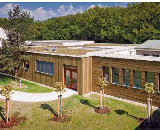
Budovy nových unikátních laboratoří dokončené v roce 2008
